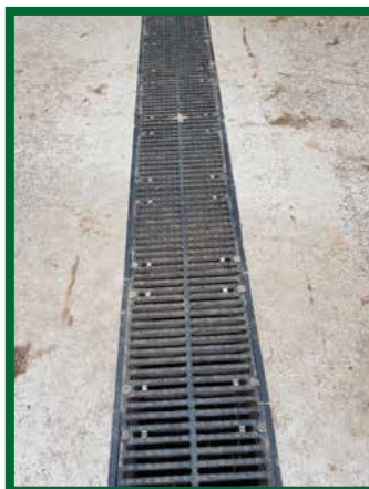
Odvodňovací žľab na miestnej komunikácii zo „Sviniarky“
