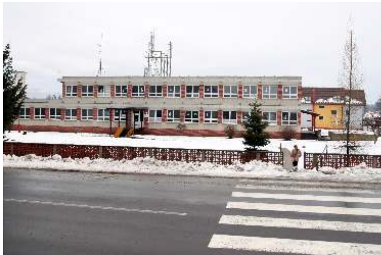
Budova školy po osadení nových okien a oprave strechy
